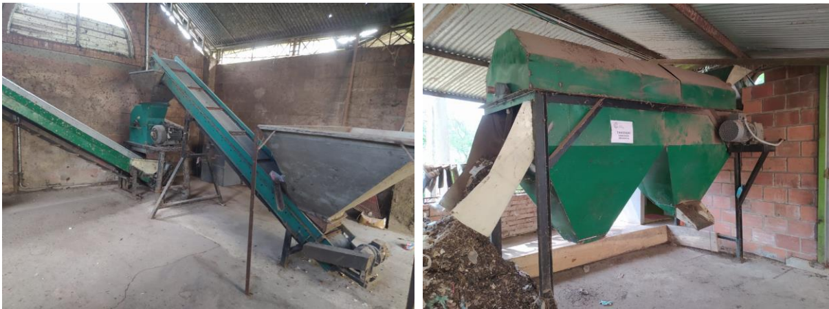
Fotos proceso Planta de Tratamiento
